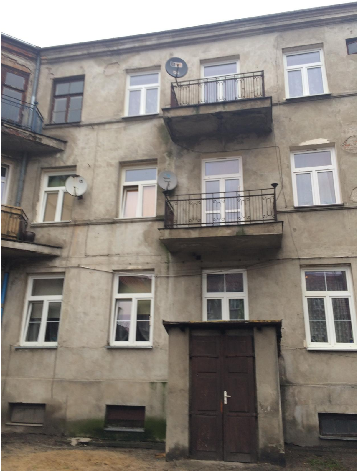
zdjęcie 3. widok od strony podwórka
