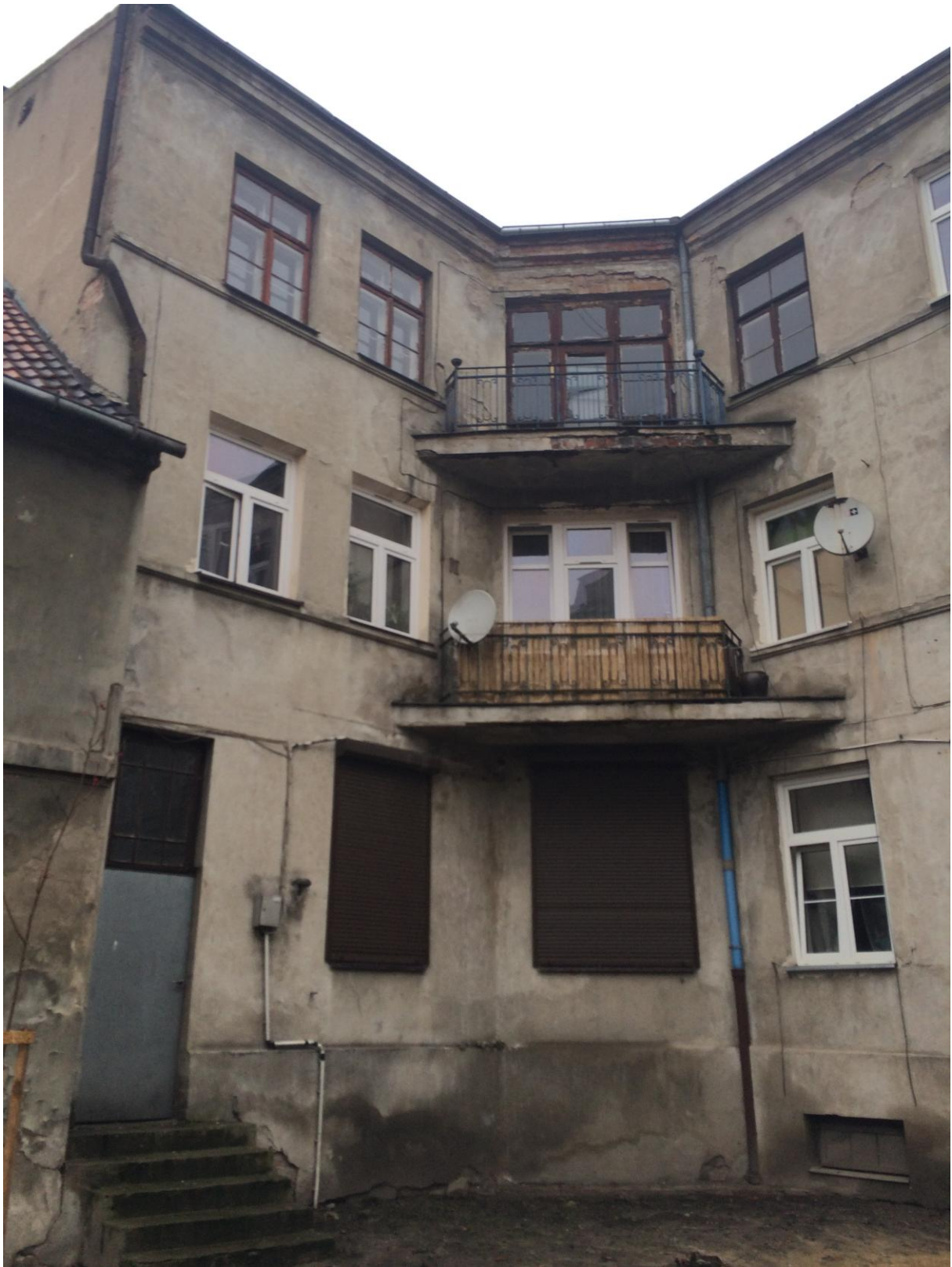
zdjęcie 2. widok od strony podwórka
